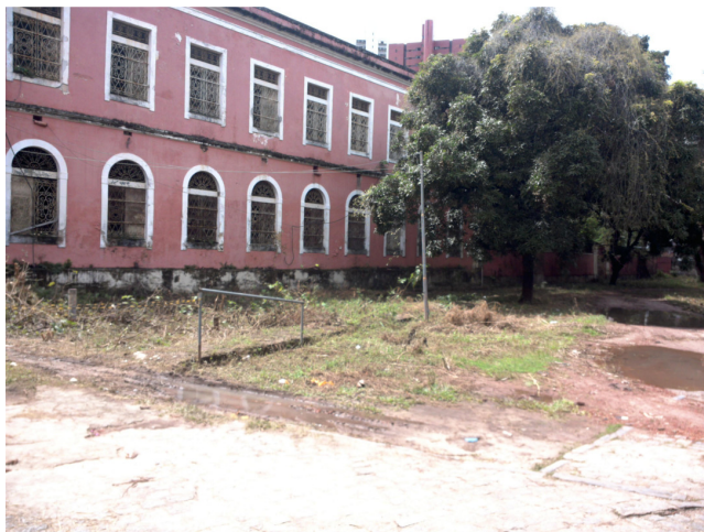
24.1. Fachada da Unidade
