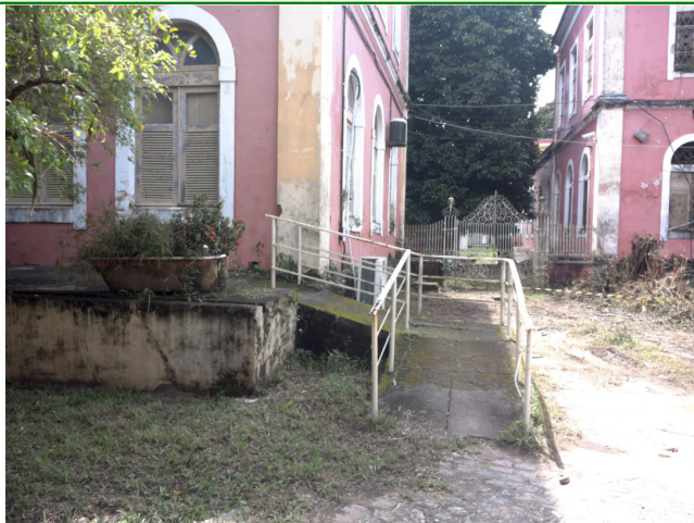
24.8. Rampa de acesso a entrada central da Unidade
