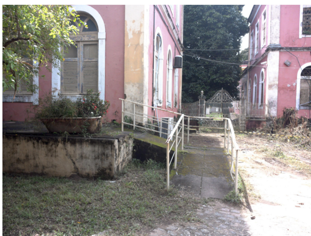
24.2. Fachada da Unidade e Entrada - Rampa
