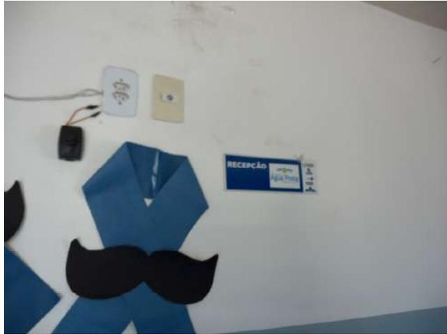
21.38. Placa da recepção + tomada com fiação exposta
