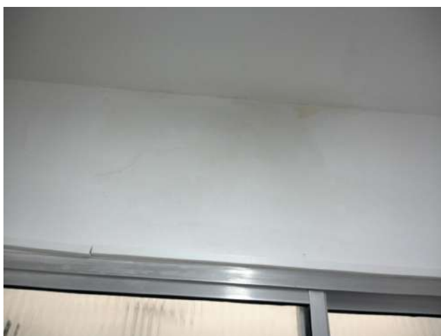
21.44. Sala dos agentes - sinais de infiltração
