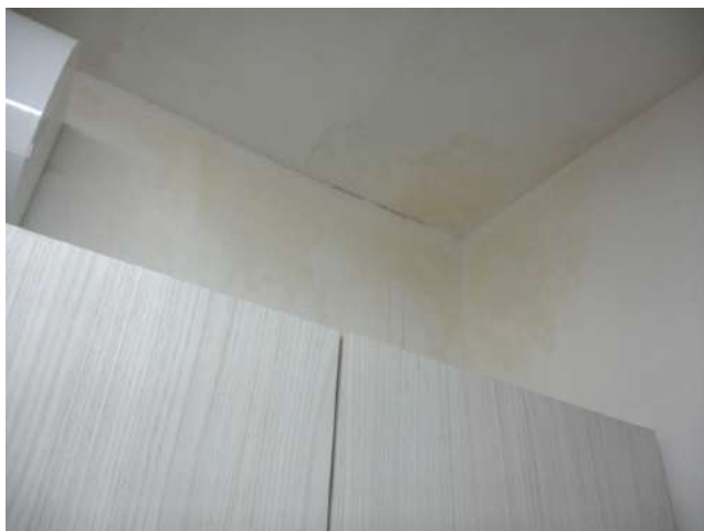
21.44. Sala dos agentes - sinais de infiltração
