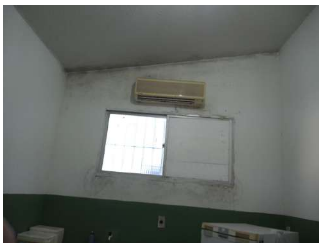
17.9. Sala de vacinas com sinais de infiltração
