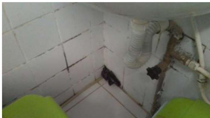
26.18. Orifício para passagem da instalação hidráulica da cadeira do dentista, este foi ocluído para evitar a entrada de baratas e escorpiões
