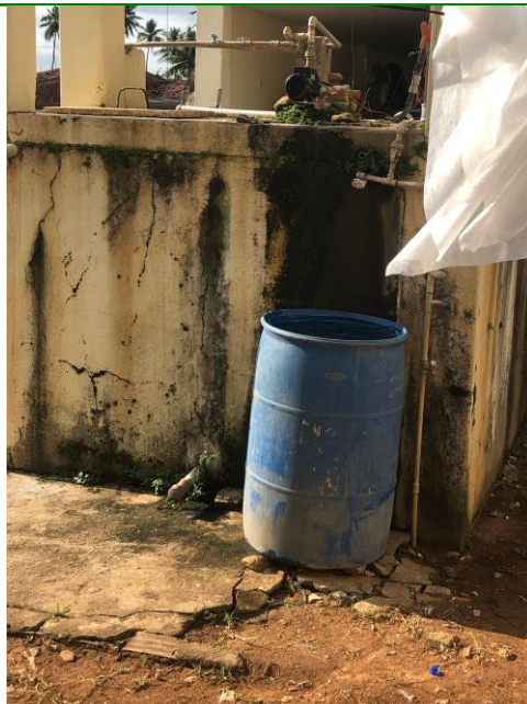
29.17. Parte externa da Lavanderia
