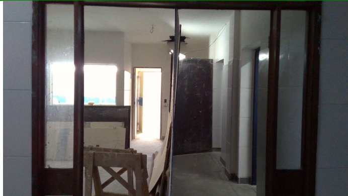
26.31. Entrada para sala de parto de gestantes suspeita de covid (observar reforma ao lado)
