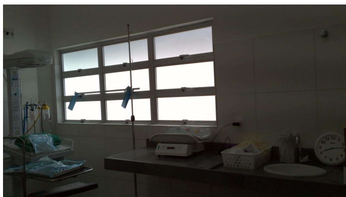
26.27. Sala de cesárea (observar pia e janelas que se abrem para fora)
