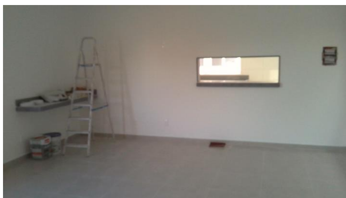
23.6. Novo refeitório - reforma
