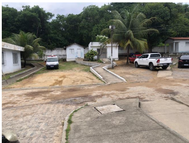
13.1. Área externa onde existe previsão para construção de novo prédio
