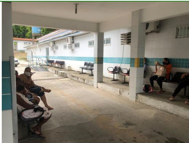
13.8. Entrada do hospital
