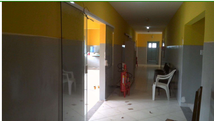
41.10. Hospital em reforma (foto 1)
