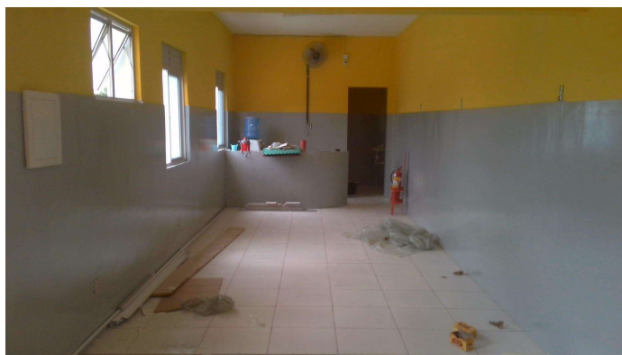
41.11. Hospital em reforma (foto 2)
