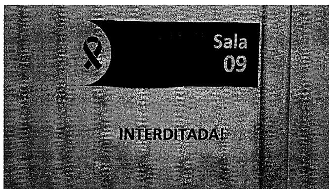
21.30. SALA 9 - INTERDITADA - entra água pela janela e escorre pela parede nos dias de chuva. Mofo no teto.
