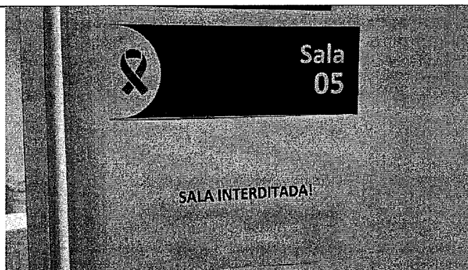
21.25. SALA 5 - INTERDITADA -Ar condicionado quebrado
