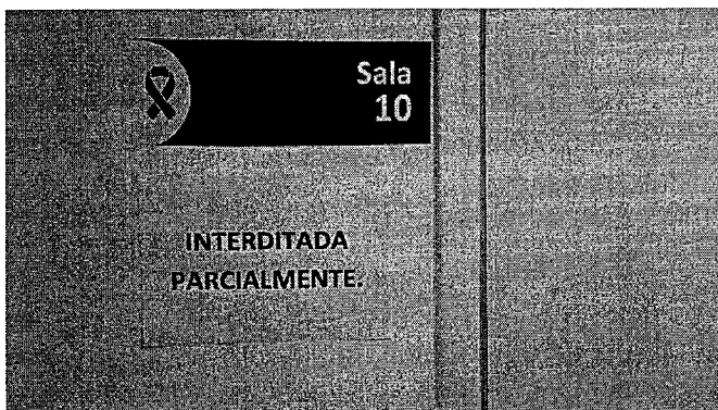
21.20. SALA 10 INTERDITADA - mofo no teto e parede.
