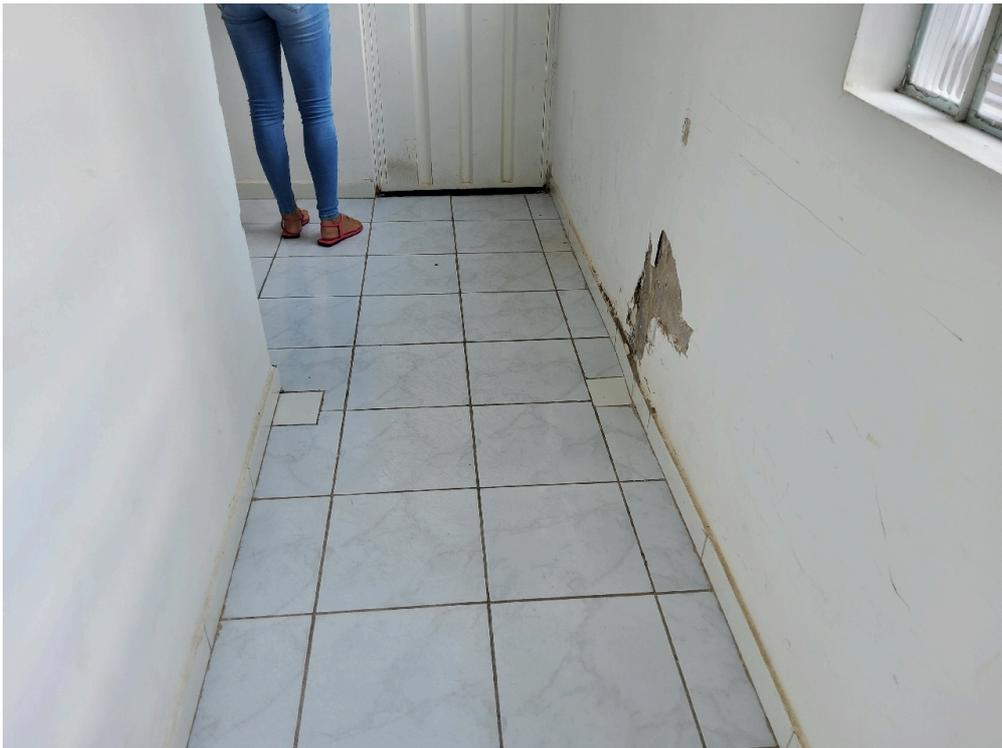
Parede com reboco caindo
