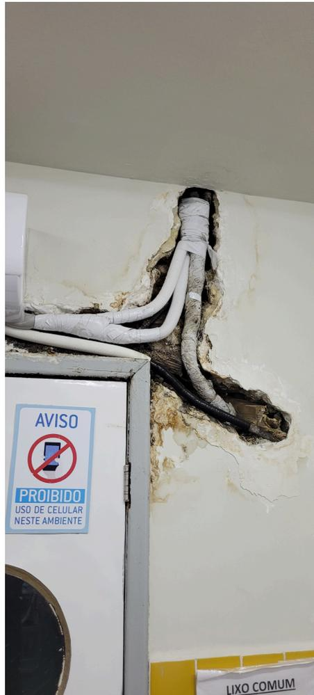
infiltrações e mofo em ar condicionado da sala de estabilização ou sala vermelha
