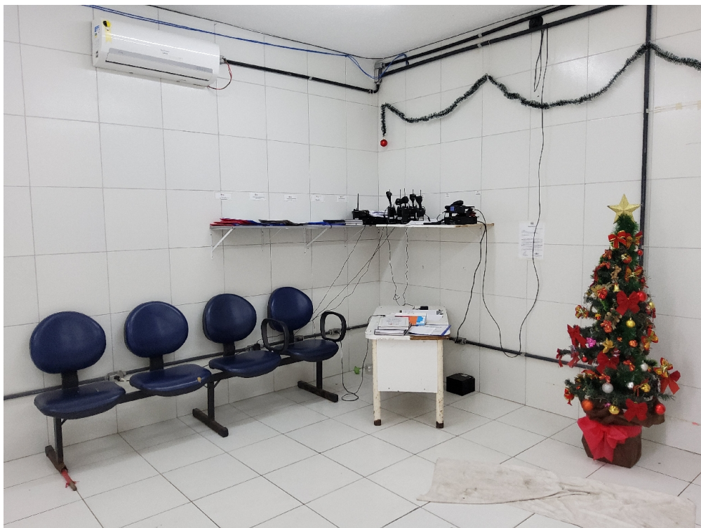
Recepção e sala de espera
