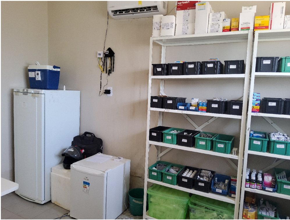
Farmácia (ar-condicionado vazando - observar balde para apagar a água)
