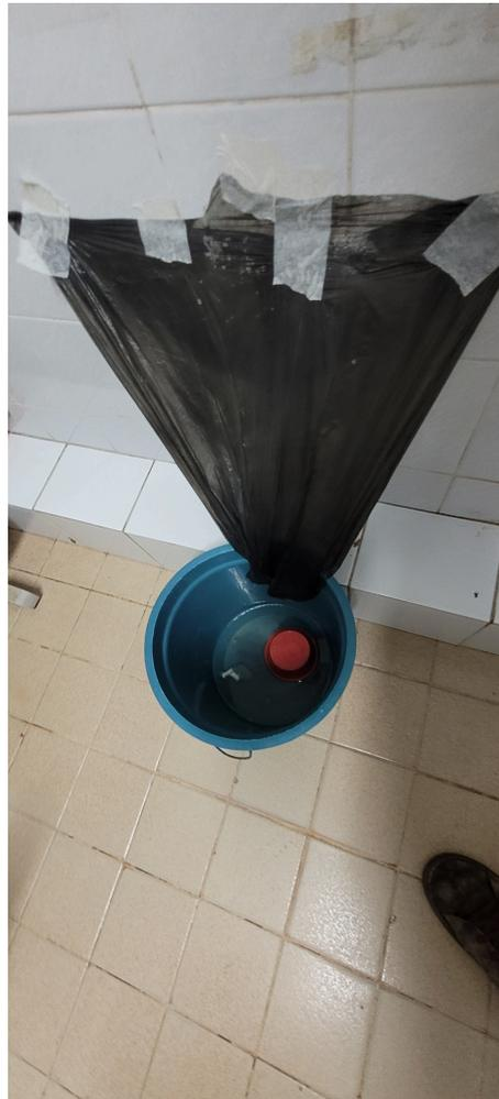
detalhe da calha improvisada para coletar gotejamento de ar condicionado na sala de vacinação
