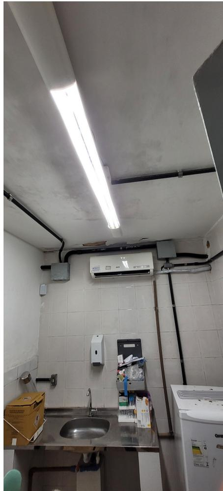
sala para coleta de exames laboratoriais com a geladeira de insulina à direita. no teto podem se observar áreas com infiltração
