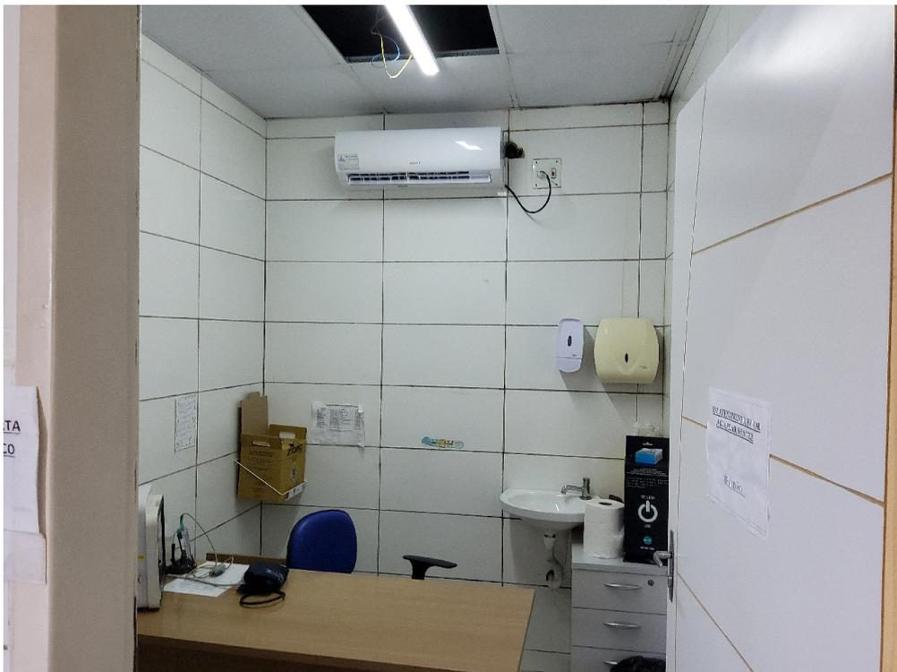
Sala de classificação de risco (observar teto faltando forro e com fios aparentes)
