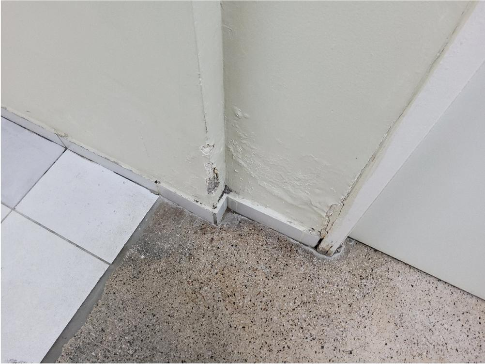
Infiltração com reboco caindo
