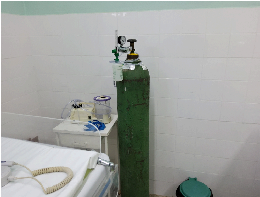
Item não conforme: Cilindro de oxigênio não fixado à parede
