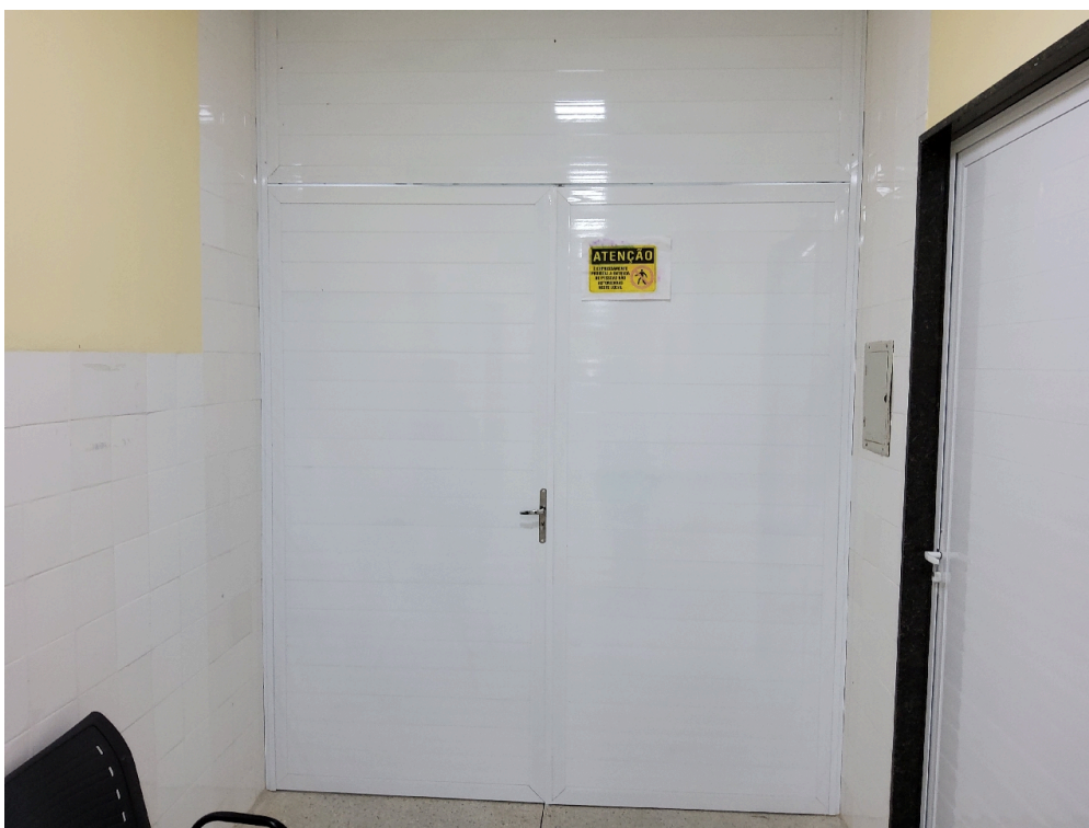
Entrada do bloco cirúrgico
