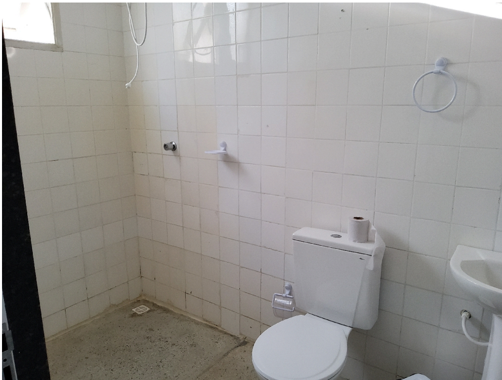
Banheiro do pré-parto
