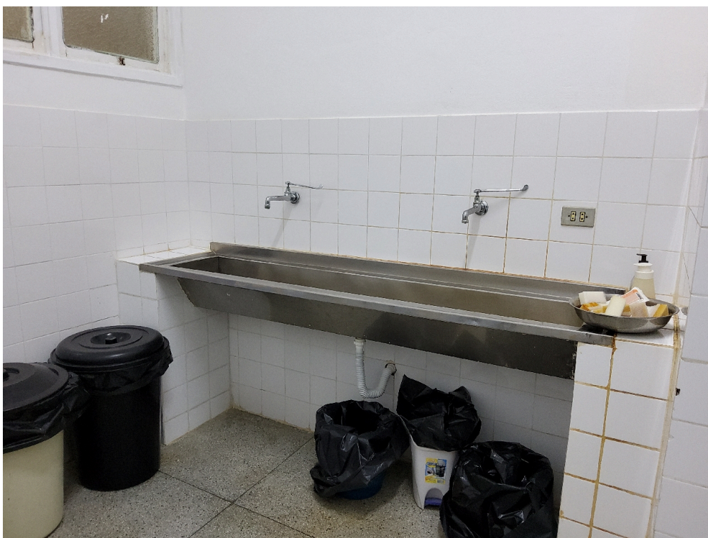
Lavabo do bloco cirúrgico
