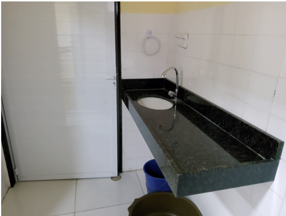
Banheiro da enfermaria (foto 2)
