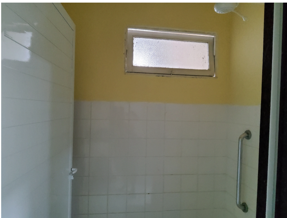
Banheiro da enfermaria (foto 1)
