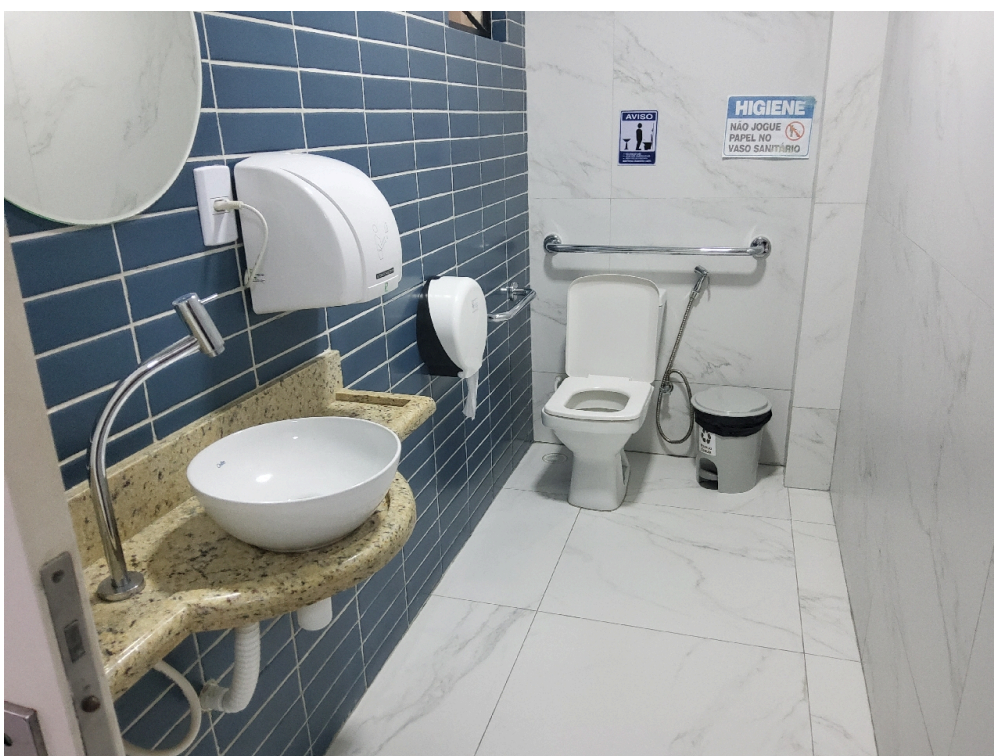
Sanitários acessíveis/adaptados para portadores de necessidades especiais – PNE
