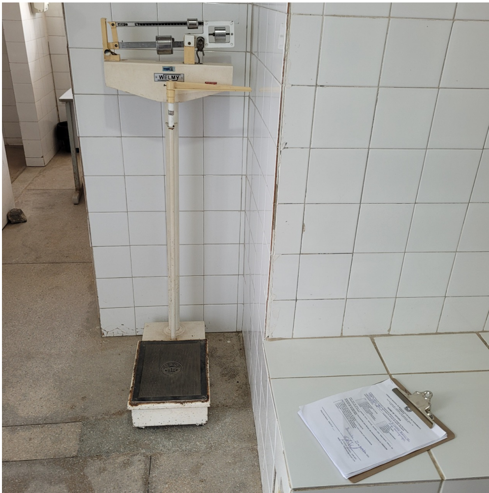
balança no corredor evidencia falta de sala de pré-consulta de enfermagem
