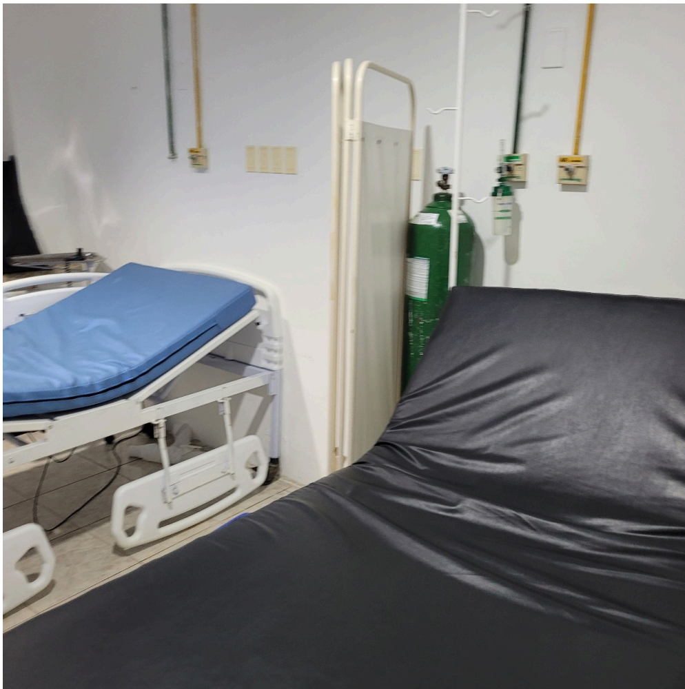
sala de observação com rede de gases e cilindro de oxigênio sem fixação
