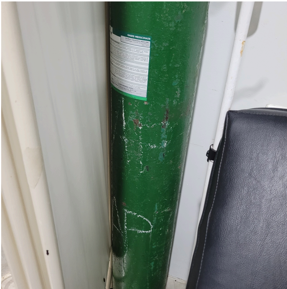
cilindro de oxigênio sem fixação
