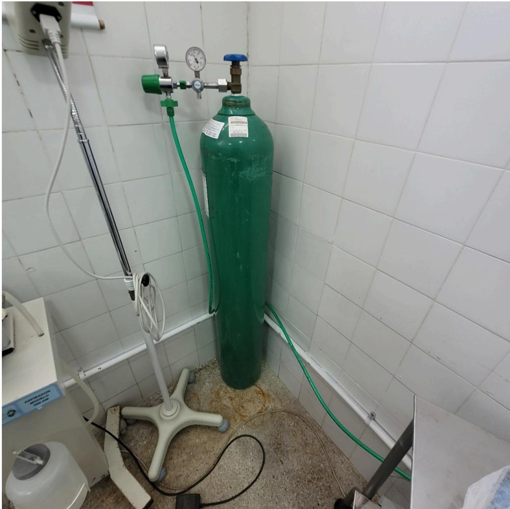
cilindro de oxigênio na sala vermelha sem fixação
