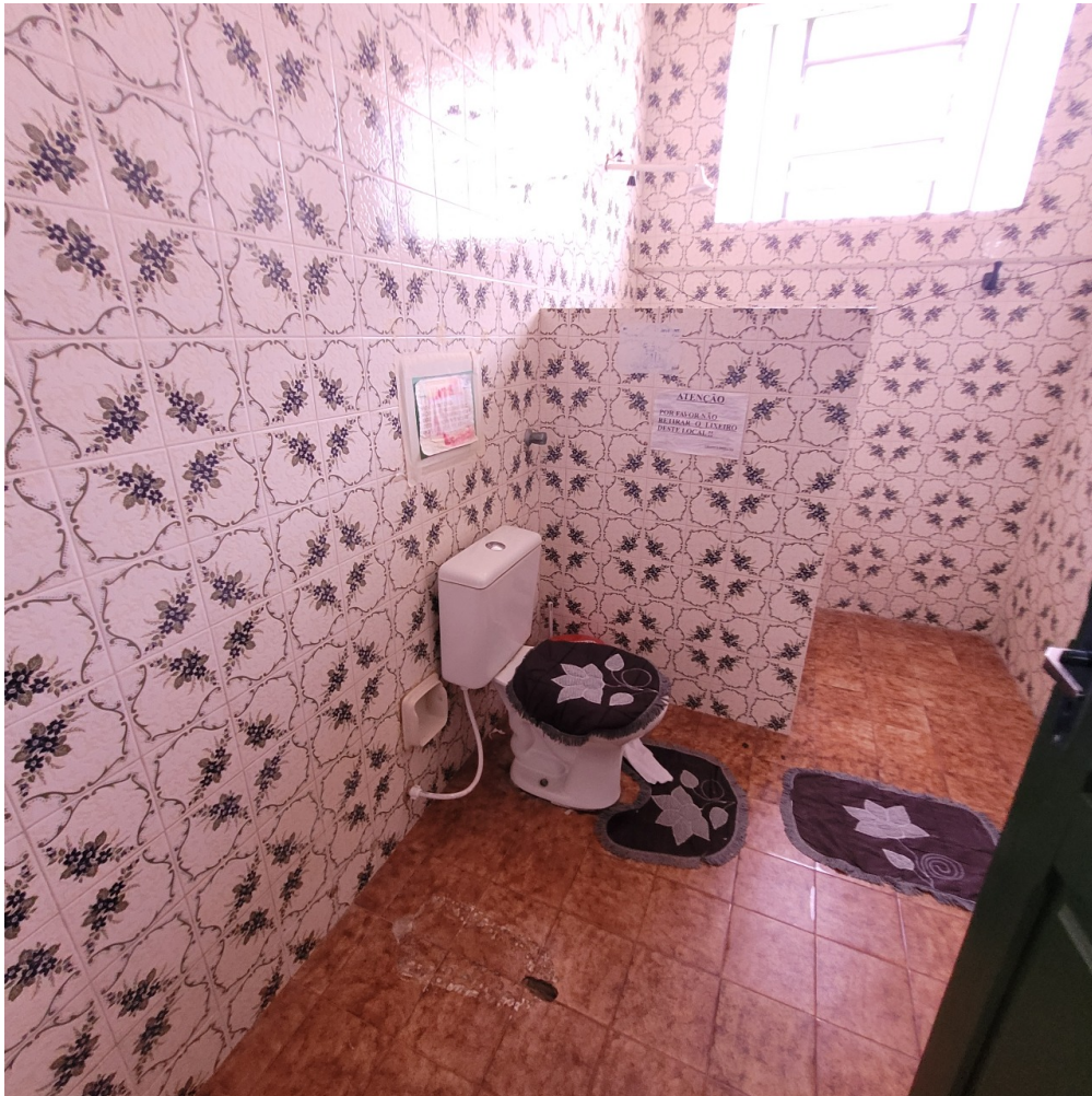
banheiro dos trabalhadores
