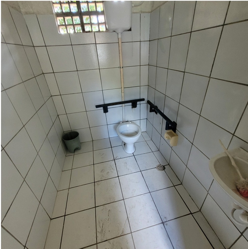
banheiro dos usuários
